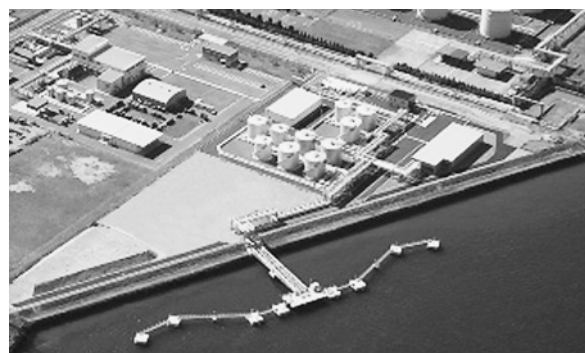
一般企業向けケミカルタンクターミナルの全景
