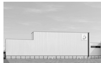
17年の完成を目指し建設が進む新工場
