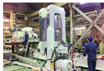
24型4段圧延機、組立風景
