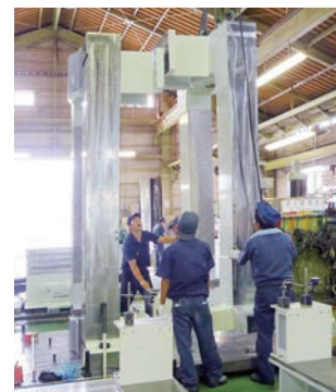
30型ロールプレス機の スタンド組付け風景
