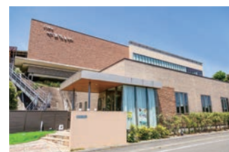
本社事務所外観
