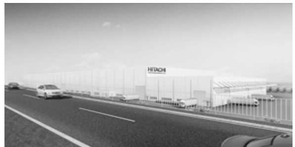
常陸那珂臨港工場の隣接地に建設が進む新工場（完成予想図） 提供：日立建機株
