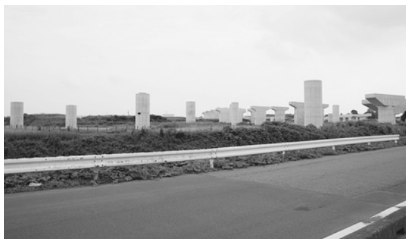
建設が進む圏央道～(仮)五霞IC周辺(8月21日現在)
